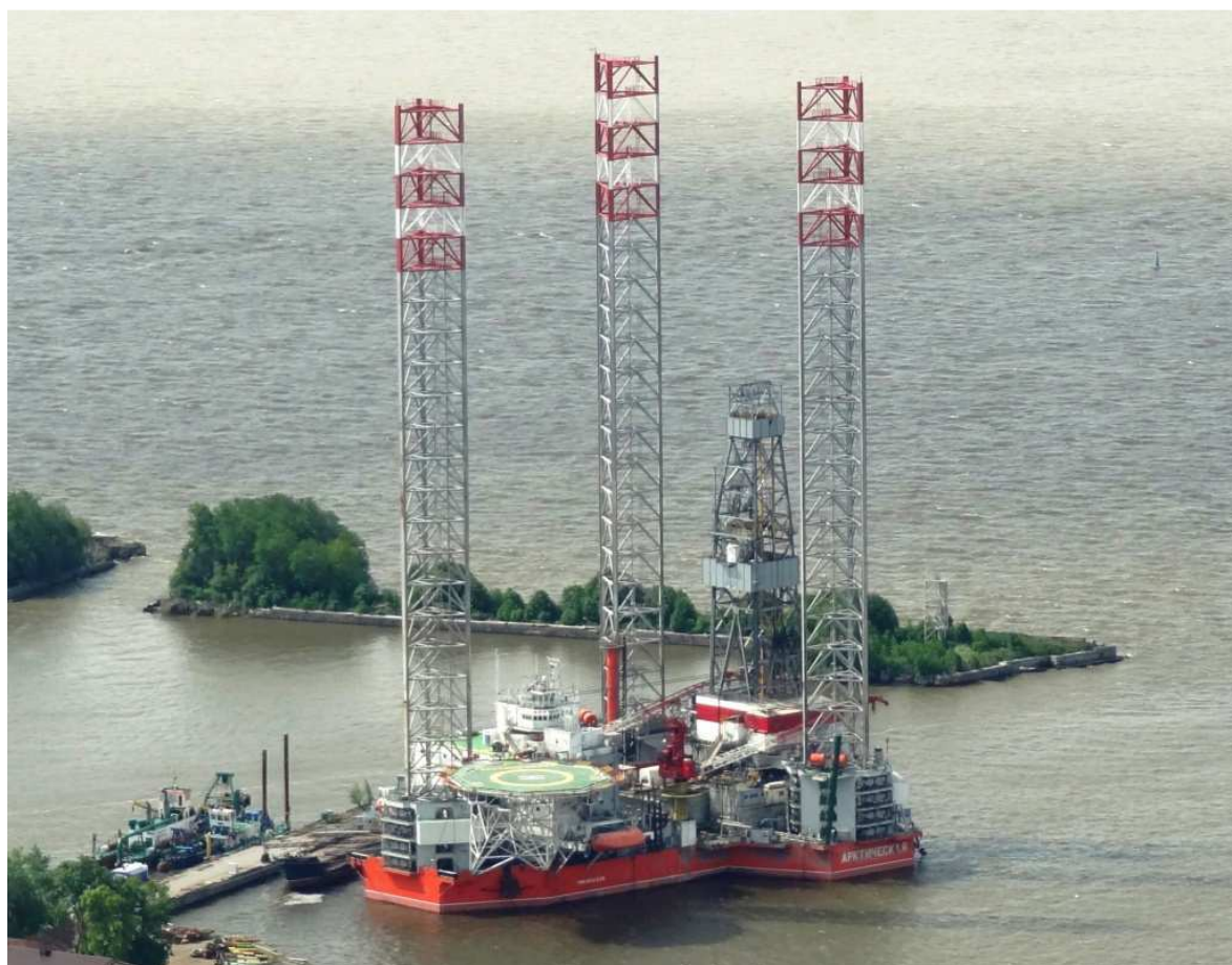
Рис. 2. СПБУ "Арктическая" на Морском заводе в Кронштадте (фото авторов, 11.06.15)
